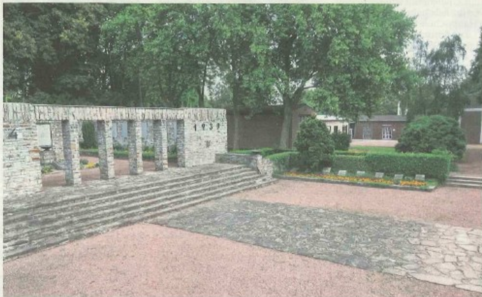
Hier könnte das Friedhofscafé stehen: Zwischen dem Betriebsgebäude (hinten) und der Ehrenmal-Anlage (vorn) soll ein vier mal neun Meter großes Zelt errichtet werden.
